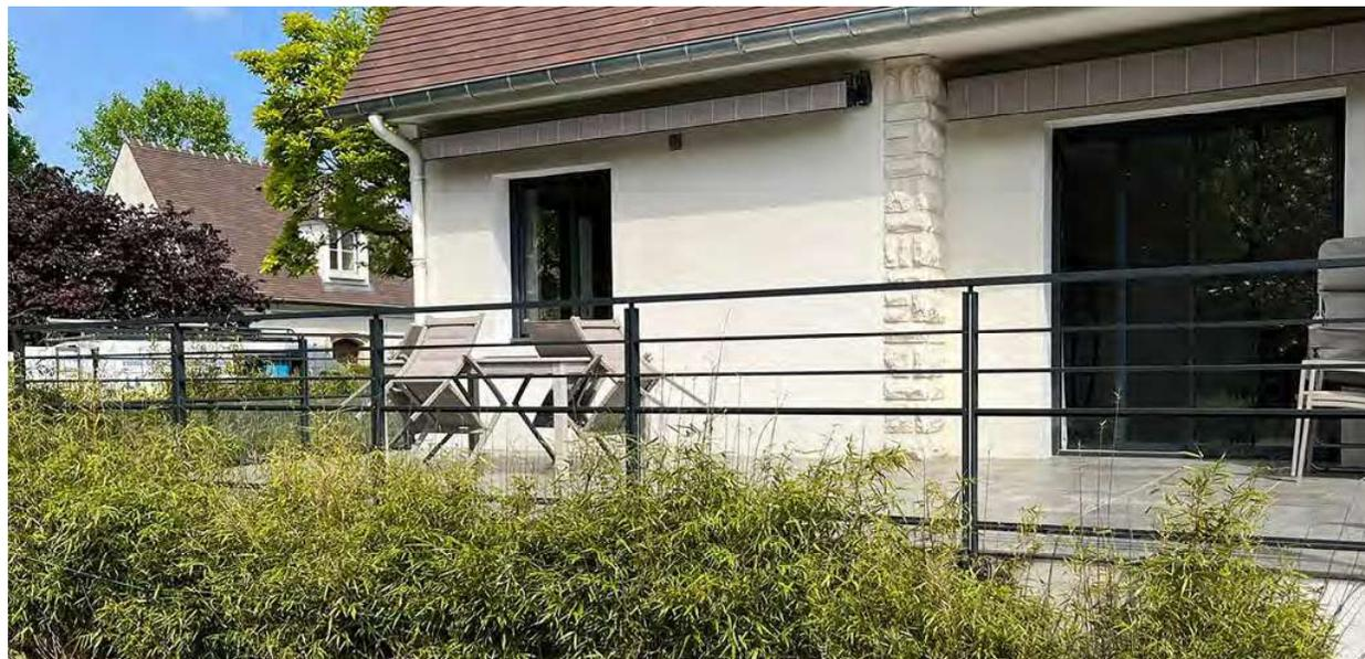
Lisses avec remplissage en soubassement. Tôle microperforée. Pose sur dalle et à sceller. *RAL 7037.*
