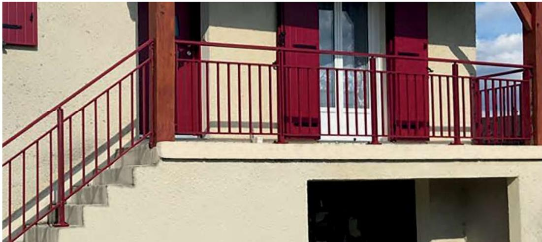
Barreaudé sous lisse intermédiaire. Pose en nez de dalle extérieure. *RAL 7035.*
